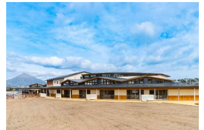
(仮称)高浜町立認定こども園新築工事(福岡県)
