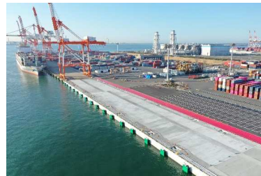
令和2年度 名古屋港飛鳥・頭東岸壁(-15m) 棧橋上部工事(その2) (愛知県)
