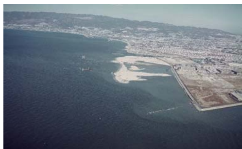
昭和46年当時の鳴尾埋立工事の様子
