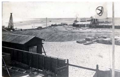
戦前の鳴尾工事現場の風景
