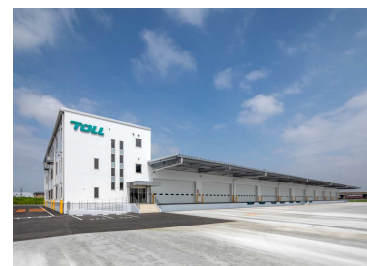
(仮称) トールエクスプレスジャパン名古屋支店新築工事(愛知県)
