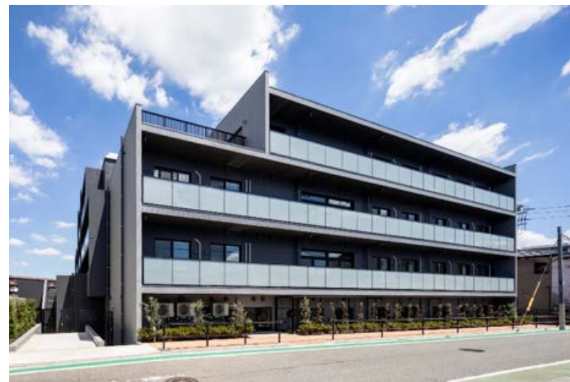
徳丸四丁目新築工事（東京都）
