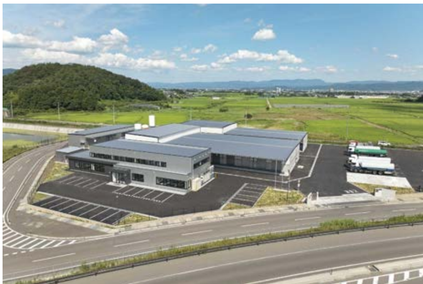
（仮称）高圧ガス工業(株)福島高圧ガス流通センター 新築工事（福島県）
