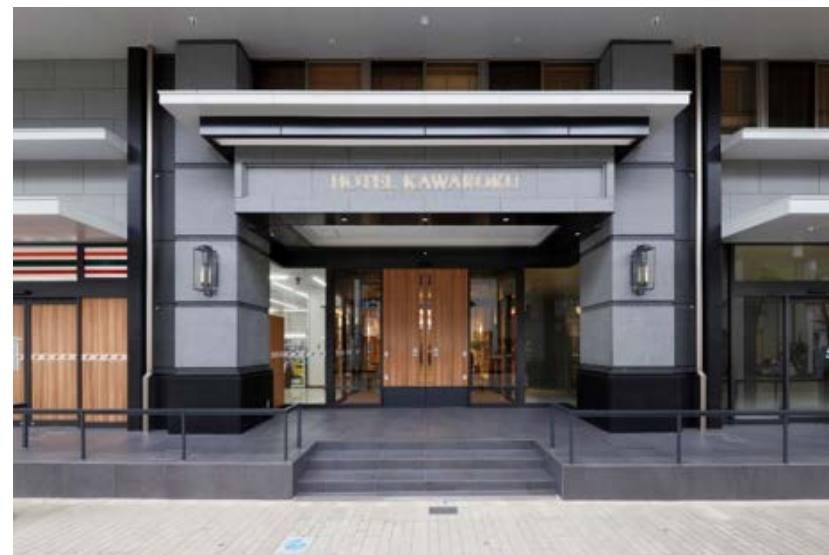
ホテル川六第3期増改築工事（香川県）
