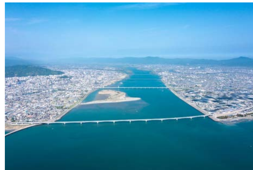
四国横断自動車道 吉野川大橋工事（徳島県）
