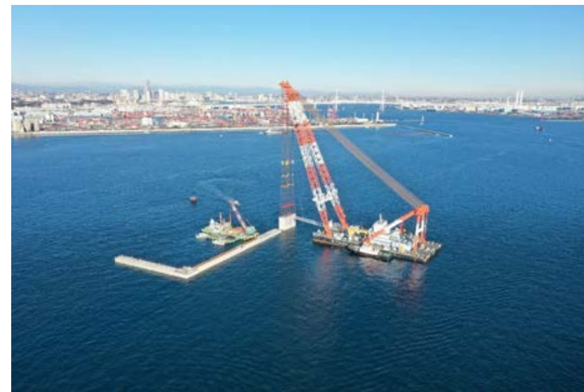
横浜港新本牧地区護岸（防波）東側築造工事（神奈川県）
