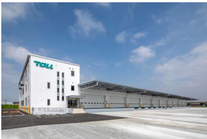
（仮称）トールエクスプレスジャパン名古屋支店新築 工事（愛知県）
