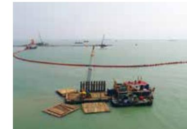
インドネシアの伝統的な工法のひとつである「竹杭」を使って護岸の基礎を構築しています
