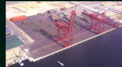
阪神・淡路大震災で被災した岸壁のなかでも最速施工で供用開始に至った六甲アイランド岸壁工事（兵庫県）
