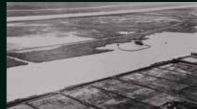
江戸時代から洪水に悩まされていた利根川の治水事業たる浚渫工事（千葉県）
