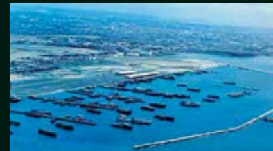
フィリピンの食糧事情改善に貢献したナボタス漁港建設工事（フィリピン）
