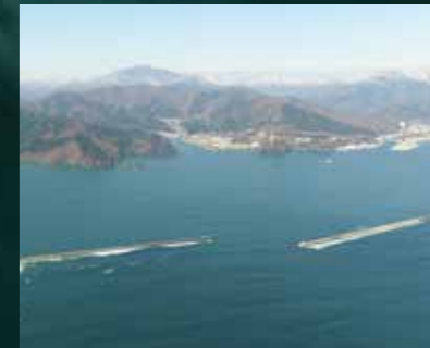
東日本大震災で被災した釜石湾口防波堤だが、7年後に復活。再び津波から街を守っている（岩手県）
