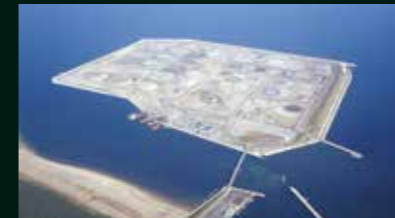
現在の国内消費量9日分を備蓄している志布志石油備蓄基地の施工風景（鹿児島県）
