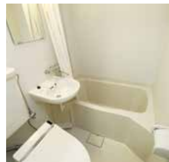
「拓海」船内の女性専用居室に設置されたユニットバス
