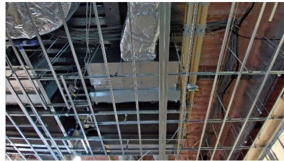
Skydio2 による天井部の撮影
