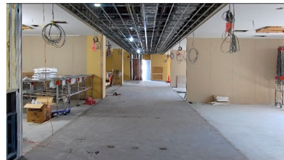
BIM モデルと同位置の施工状況
