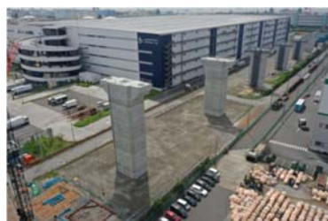
川崎港臨港道路東扇島水江町線東扇島アプローチ部橋梁下部工事(神奈川県)
