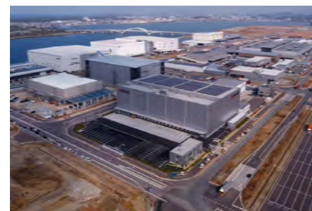
冷凍倉庫建設
