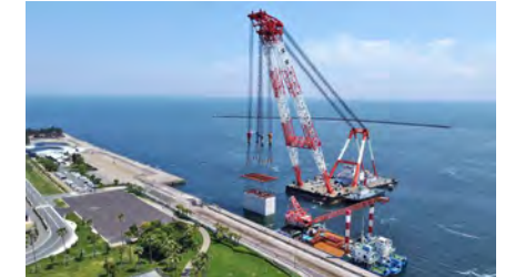
岸壁建造工事
