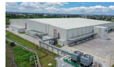
物流倉庫建設
