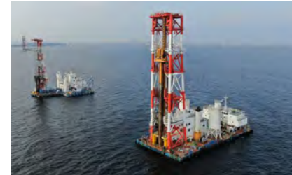
海上地盤改良工事
