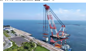
岸壁築造工事
