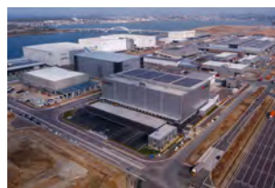
冷凍倉庫建設
