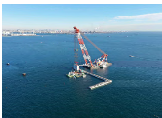
横浜港新本牧地区護岸（防波）東側築造工事 （神奈川県）
