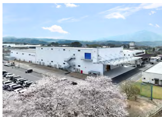
ムラテックメカトロニクス株式会社大分工場第2工場棟建設 工事（大分県）
