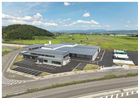
高圧ガス工業（株）福島高圧ガス流通センター新築工事 （福島県）
