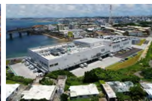
食品工場建設
