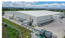
物流倉庫建設
