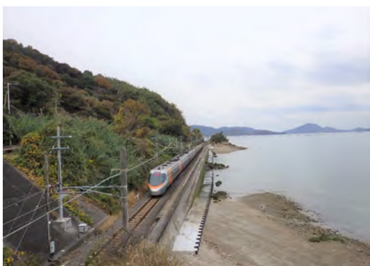
予讃線海岸寺・詫間間護岸復旧その4工事 （香川県）
