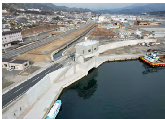
大船渡海岸茶屋前地区災害復旧（23災166号） 水門土木ほか工事（岩手県）
