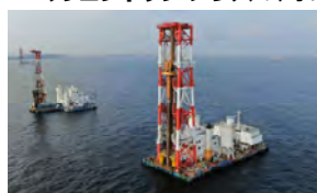
海上地盤改良工事
