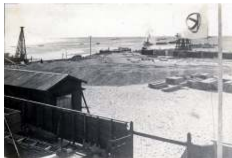
戦前の鳴尾工事現場の風景
