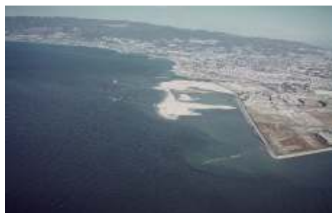
昭和46年当時の鳴尾埋立工事の様子
