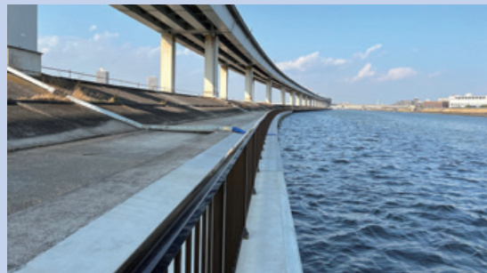
R3荒川中堤北葛西一丁目地区護岸改築工事
