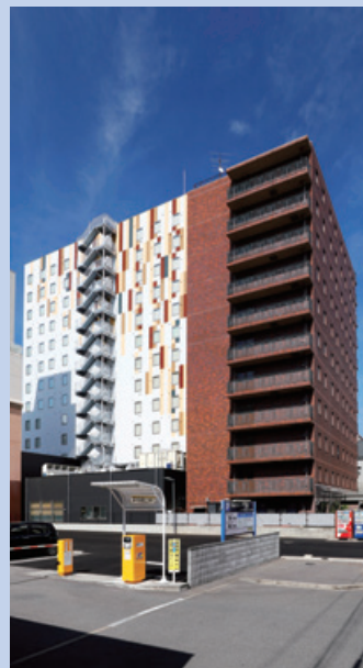
ホテル川六第3期増改築工事
