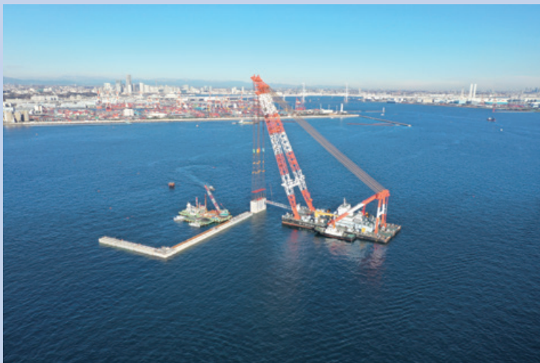
横浜港新本牧地区護岸（防波）東側築造工事
