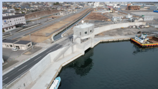
大船渡港海岸茶屋前地区災害復旧(23災166号)水門土木ほか工事
