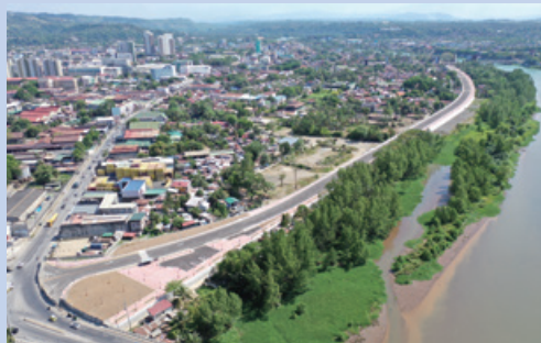
全長2.3kmの河川堤防を築造
