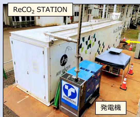
小型CO<sub>2</sub>回収装置「ReCO<sub>2</sub> STATION」と発電機
