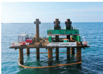
杭の引抜き実験の様子
