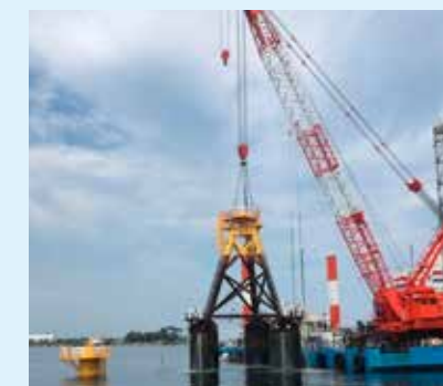
複数のバケットを有するマルチタイプのサクシオンバケット
