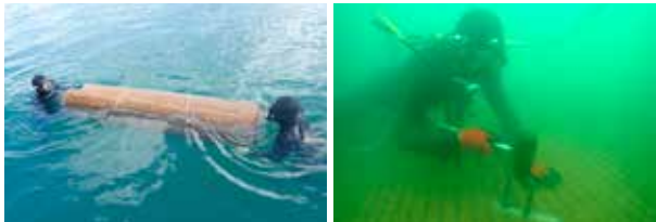
アマモ播種シートの敷設状況
