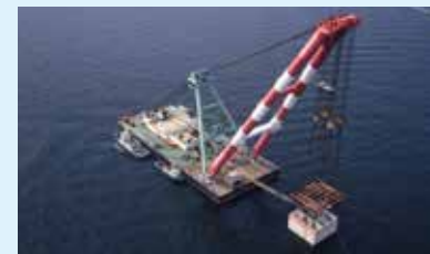
関西国際空港護岸第1号ケーソンの据付け（大阪府）
