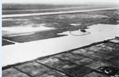
戦後の混乱期を乗り越える契機となった利根川浚渫工事（千葉県）
