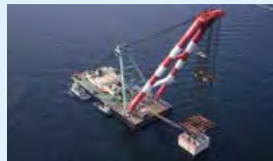
関西国際空港護岸第1号ケーソンの据付け（大阪府）
