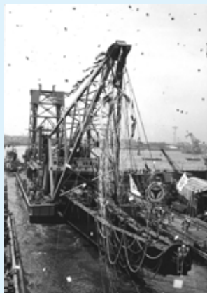
当社の技術提供により完成した世界最大級のポンプ浚渫船「第五東開丸」（1964年）
