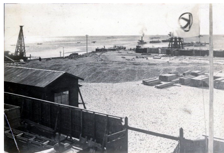
戦前の鳴尾工事現場の風景
