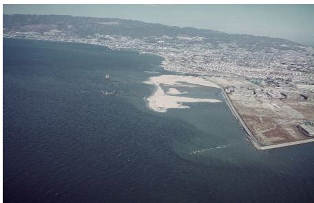
昭和46年当時の鳴尾埋立工事の様子
