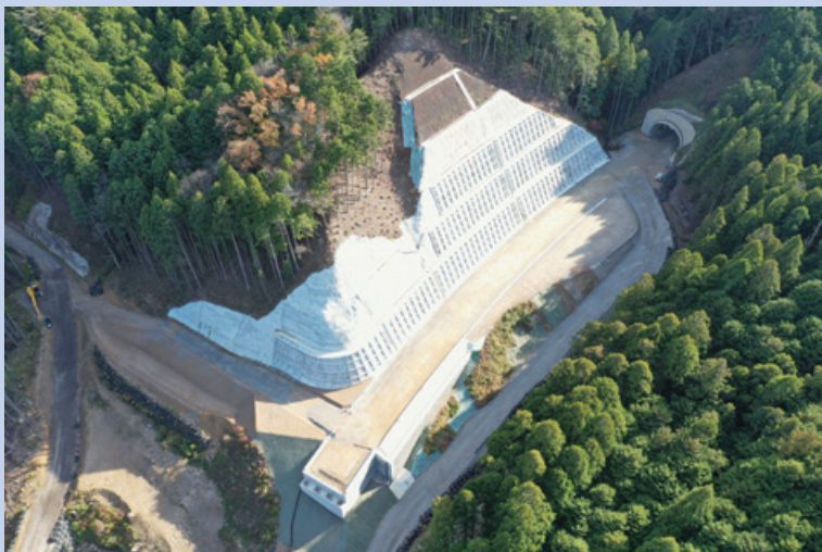
令和3年度 設楽ダム設楽根羽線3号橋左岸下部工事
