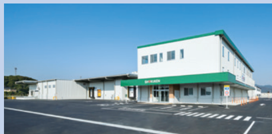
(仮称) 株式会社社研豊橋工場新築工事
