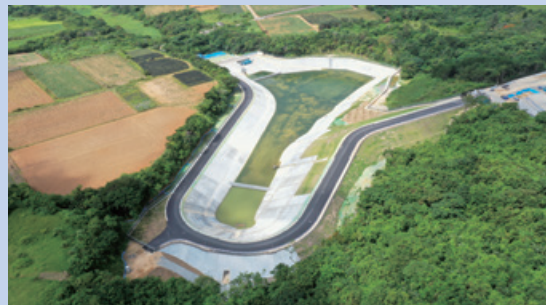
石垣島（2）駐屯地新設土木工事（その2）
