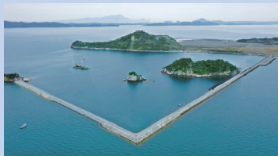
令和4年度 八代港大築島土砂処分場護岸築造工事
