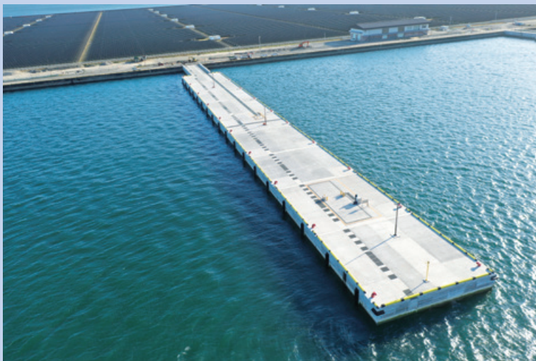
令和3年度 鹿児島港（谷山二区）係留施設築造工事（第2次）
