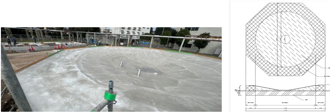
参考 汚泥消化タンク基礎のコンクリート打設後の状況と図面
