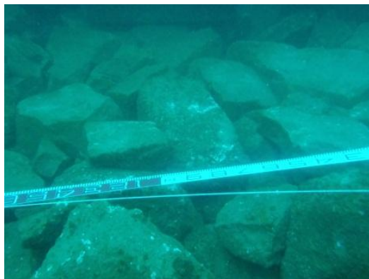
写真-2.2.1 捨石マウンド表面調査の例 1)
