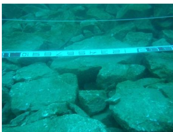
(c) 防波堤（東第一）（高知港）
