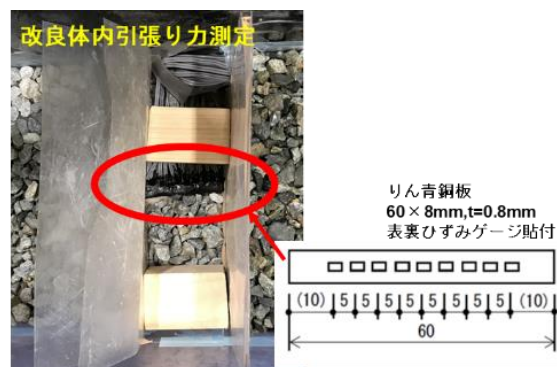
参考写真-6.2 りん青銅板の設置状況
