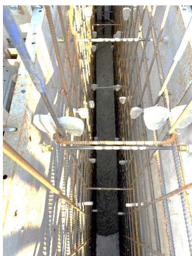
スリットケーソン壁内を流れる高流動化コンクリートの様子
