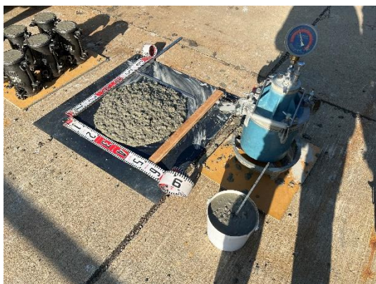
高流動化コンクリートの品質管理試験の様子
