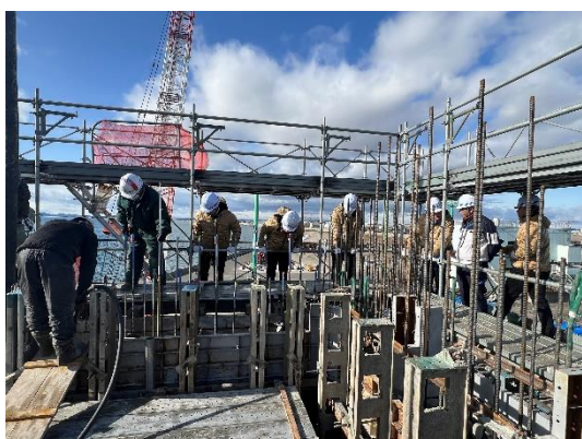
高流動化コンクリートによるスリットケーソン製作の見学①
