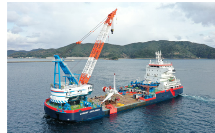
日本初の商用スケール大型潮流発電機の設置工事を五島列島「奈留瀬戸」で実施
