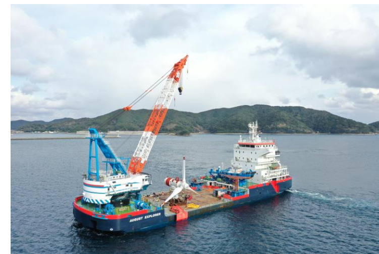
当社が所有する自航式多目的船 August Explorerを稼働し、日本初の商用スケール大型潮流発電機（船上のタービン）の海中設置工事を、五島列島において実行
