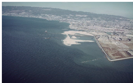
昭和46年当時の鳴尾埋立工事の様子
