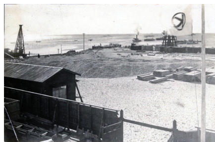
戦前の鳴尾工事現場の風景
